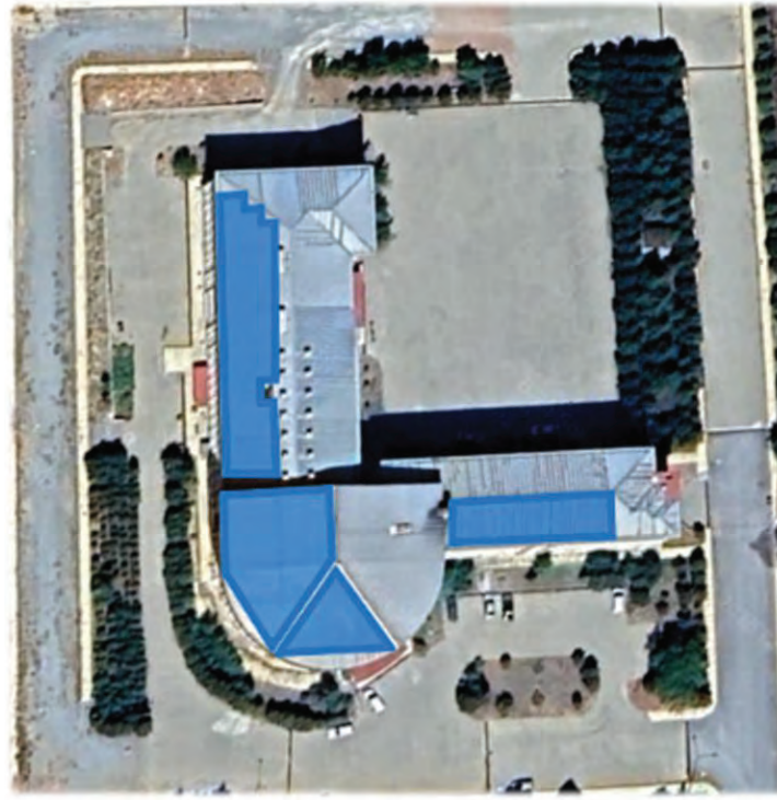
Şekil 28: Çatı GES Çalışma Alanı Uydu Görüntüsü
