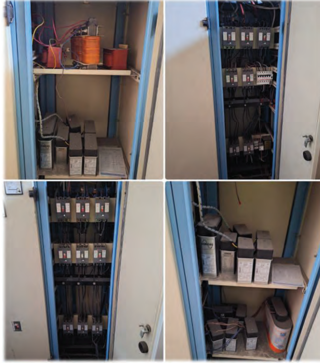
Şekil 14: Kompanzasyon Panosu Görüntüleri
